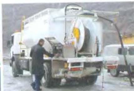
Заряжание качаемого ЭВВ с помощью СЗМ Re-Pump 12 т на карьере ОАО «Апатит» (Мурманская обл.)
