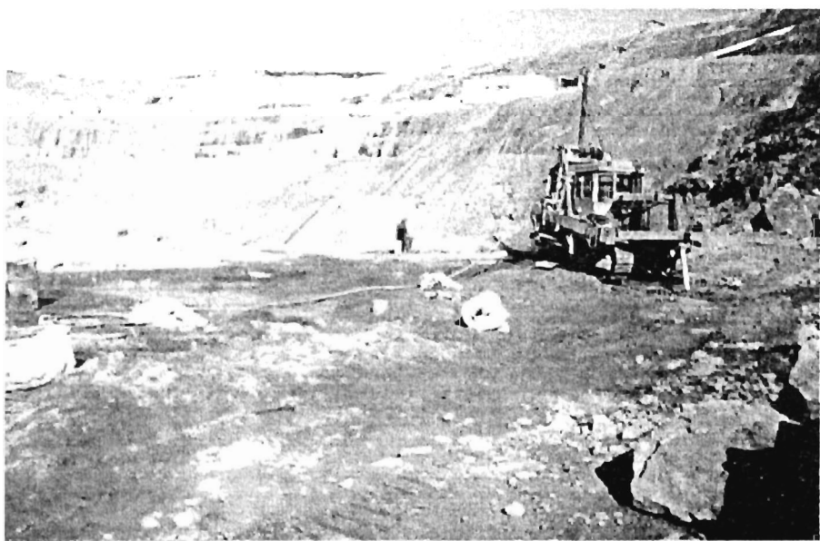
Рис.5.1.4. Вид опытного участка в процессе его обустройства (буровой станок БТС)
