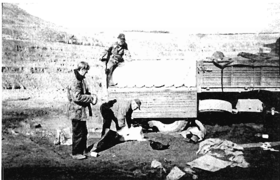
Рис 5.1.13. Этап зарядания отбойных скважин гранулолом
