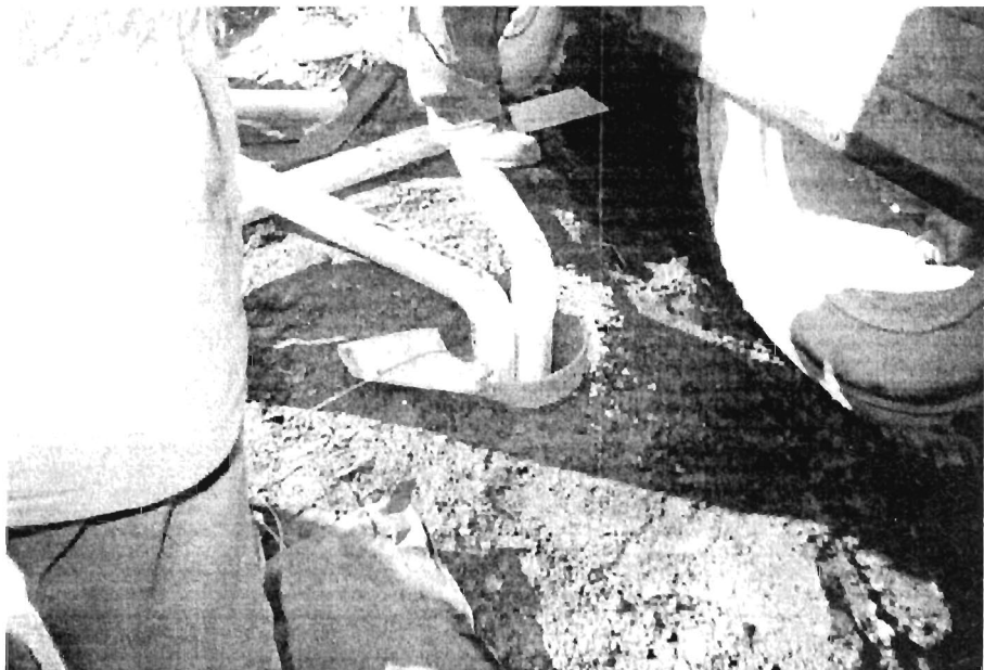
Рис.5.1.12. Этап зарядания отбойных скважин предконтурного ряда шланговыми зарядами ШЗ-4
