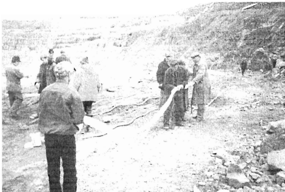
Рис.5.1.10. Этап помещения гирлянды в пластиковую оболочку
