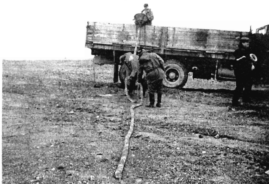
Рис.3.3.10.7. Изготовление контурного заряда в матерчатом рукаве
