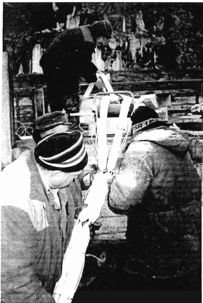
Рис.5.2.6. Заряжание контурной скважины с использованием двух гирлянд ЗКВГ-60
