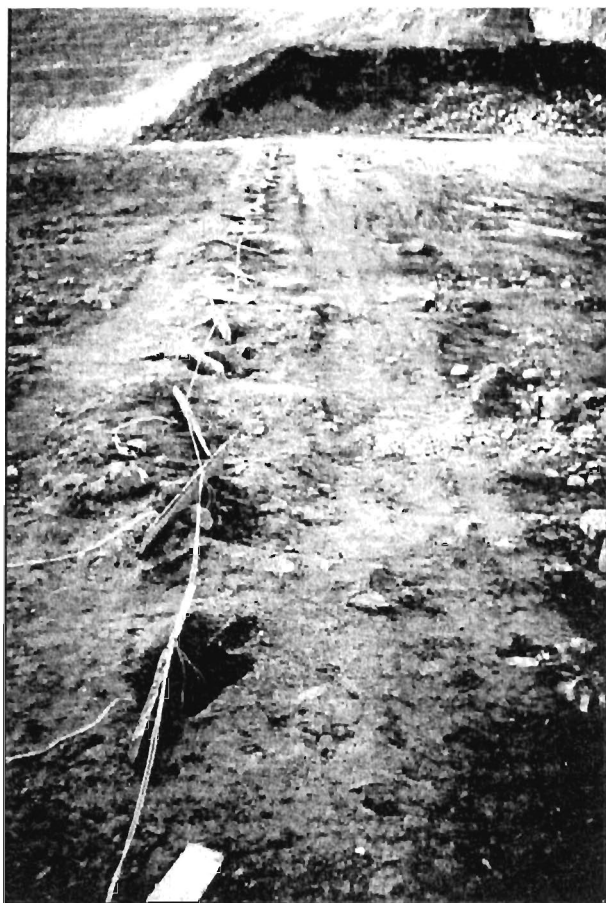
Рис.5.2.8. Общий вид контурной строчки, подготовленной к взрыву
