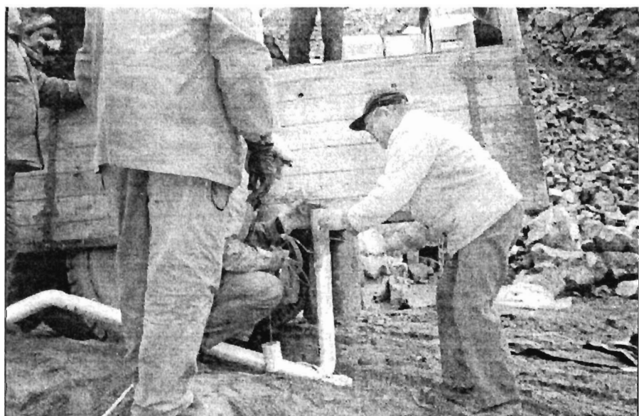
Рис.5.1.7. Этап установки промежуточных детонаторов ТГФ-850Э на шланговые заряды ШЗ-4
