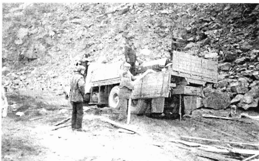
Рис.5.1.6. Этап заряжания контурных скважин диаметром 244.5 мм шланговыми зарядами ШЗ-4
