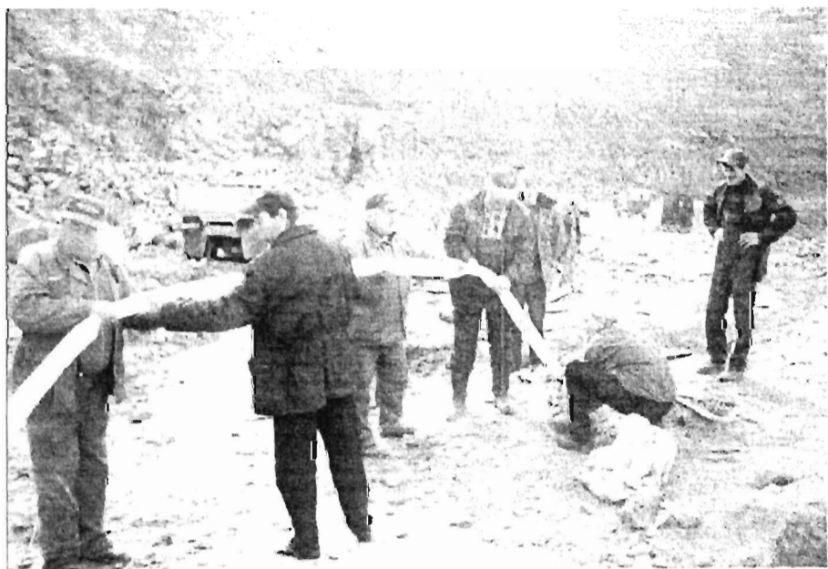
Рис.5.1.11. Этап опускания гирлянды в контурную скважину
