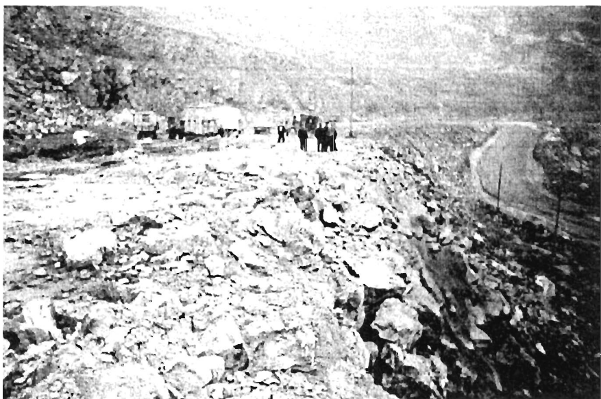
Рис.5.1.2. Общий вид опытного участка (вид с рабочей площадки)
