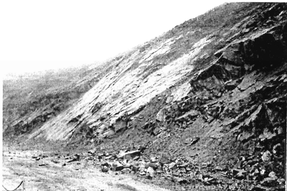
Рис.3.3.9.1. Плоскость обрушения на юго-восточном участке борта карьера рудника "Железный" ОАО "Ковдорский ГОК"
