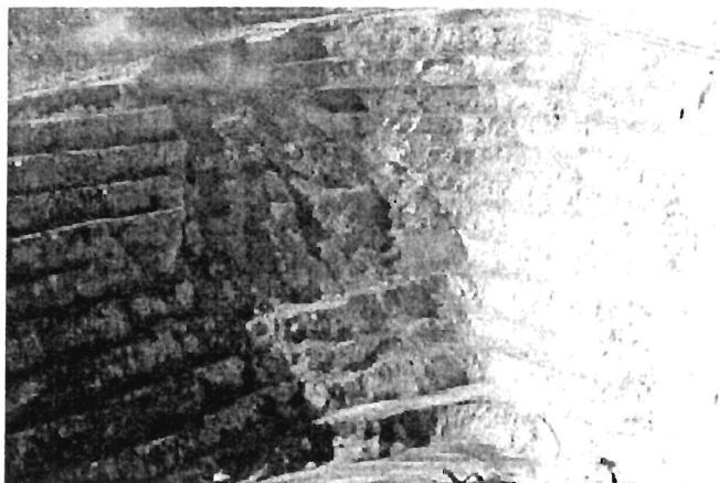
Рис. 1. Пример участка обрушения на высоту семи уступов (165 м)*
