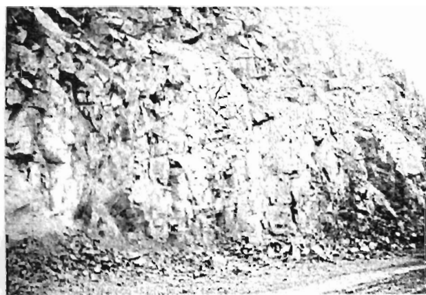
Рис.3. Заоткоска в условиях нарушенных пород
