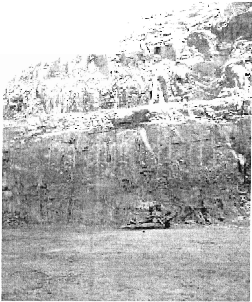
Рис.1.2.6. Вид первых 30 метров предварительного щелеобразования
