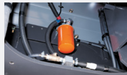
Точки контрольного осмотра, расположенные за нижним кожухом
